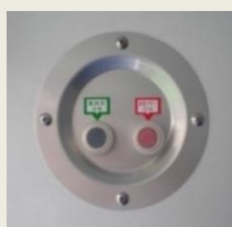
庫内灯・非常ブザー スイッチパネル
