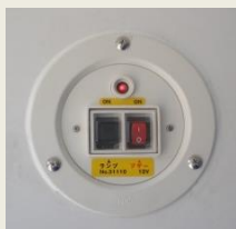
庫内灯・非常ブザー スイッチパネル
